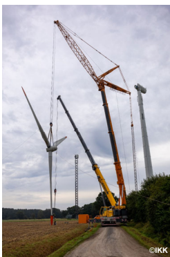
Demontage einer Windenergieanlage durch die Firma Aufwind Demontage und Recycling GmbH.
